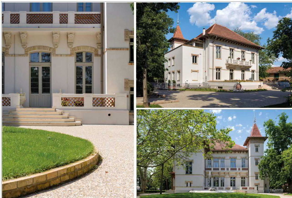
Figura nr.3 – Conacul Hagianoff (exterior)
